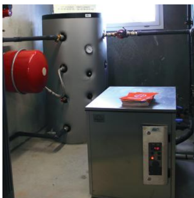
Pompe à chaleur eau/eau
